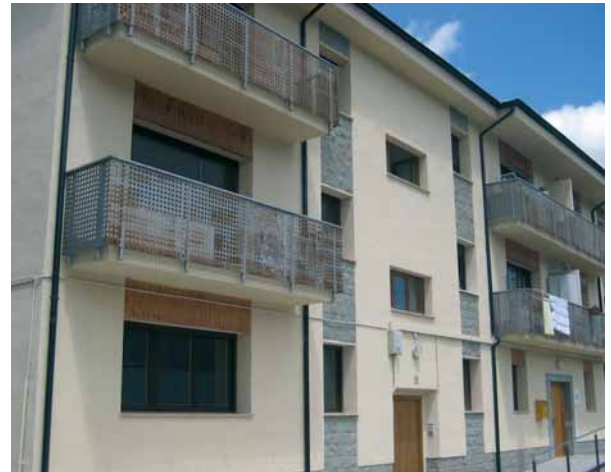
Aspecto del edificio antes de proceder a la instalación del aislamiento por el exterior Coverrock.
